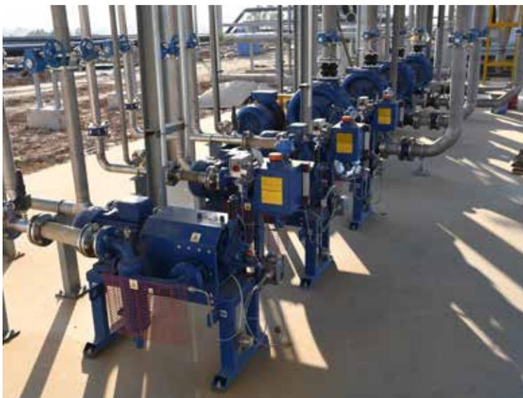
tivi a palette per biogas vengono invece comunemente impiegati per l'agitazione dei fanghi nei digestori anaerobici tramite sistemi di iniezione di gas sequenziali.
